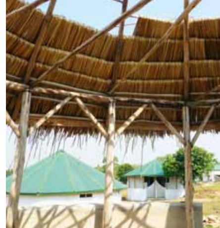
Bau eines Daches
